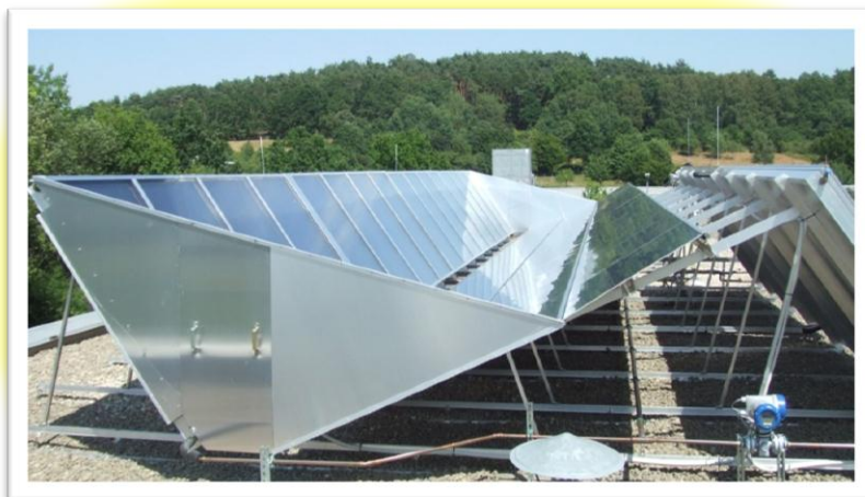
Slika 1: Polje s prototipi izboljšanih ploščatih sprejemnikov (v gradnji). Sprejemniki so dvakrat prekriti (s sončnim steklom in plastično folijo) ter opremljeni z zunanjimi odsevniki.
