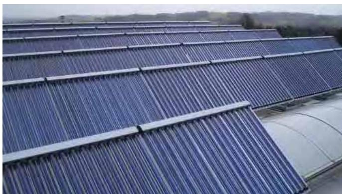
Slika 3: Vakuumski sončni sprejemniki ( $400\text{ m}^2$ ) na strehi podjetja Steinbach & Vollmann v kraju Heiligenhaus v Nemčiji.
