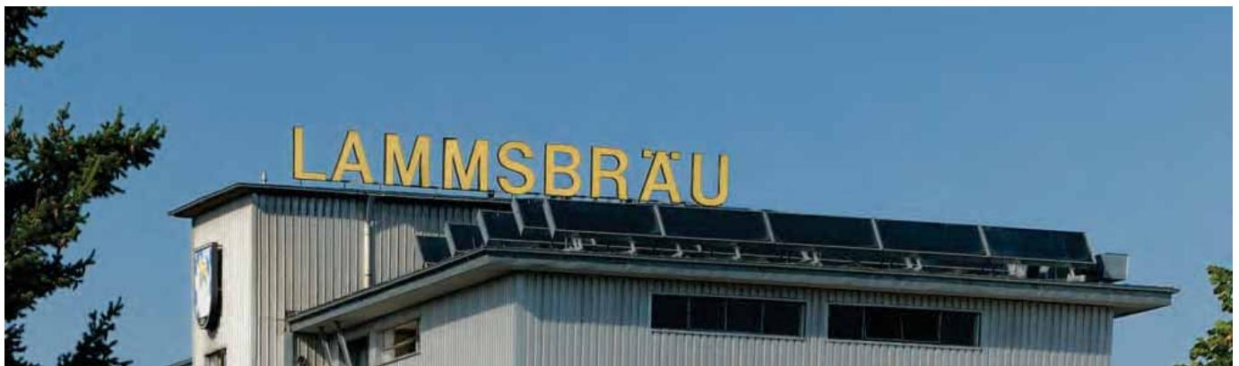
Slika 4: Ploščat zračni sprejemnik na strehi (odzračevalnik vročega zraka na desni strani)
