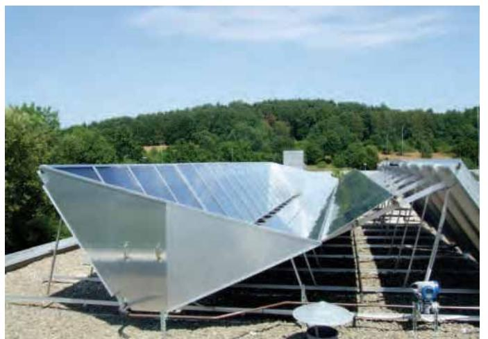
Slika 2: Polje s prototipi izboljšanih ploščatih sprejemnikov (v gradnji). Sprejemniki so dvakrat prekriti (s sončnim steklom in plastično folijo) ter opremljeni z zunanjimi odsevniki.
