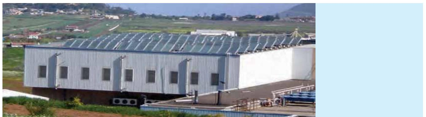
Slika 1: Ploščati sprejemniki na strehi proizvodne dvorane podjetja Montesano na Tenerifih, v La Esperanzi v Španiji
