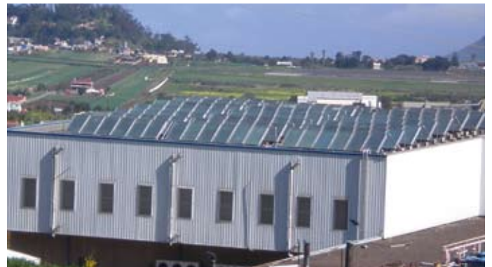
Abb. 20: Flachkollektoren auf dem Dach der Schlachtereie in Monsanto (Teneriffa, Spanien).
